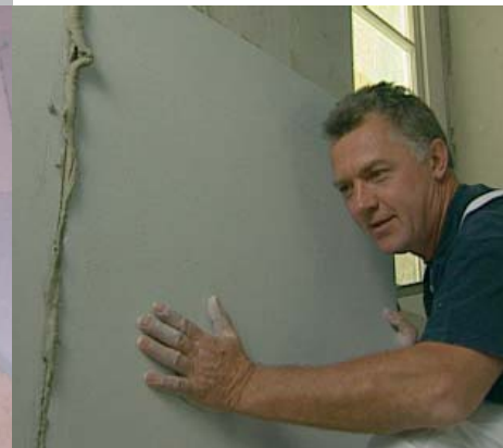
Platte einschwimmen und andrücken
