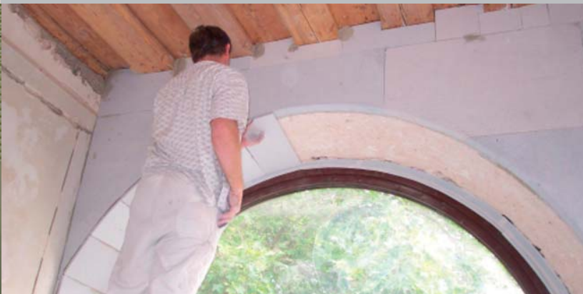
Rundbogen mit Laibungsplatten
