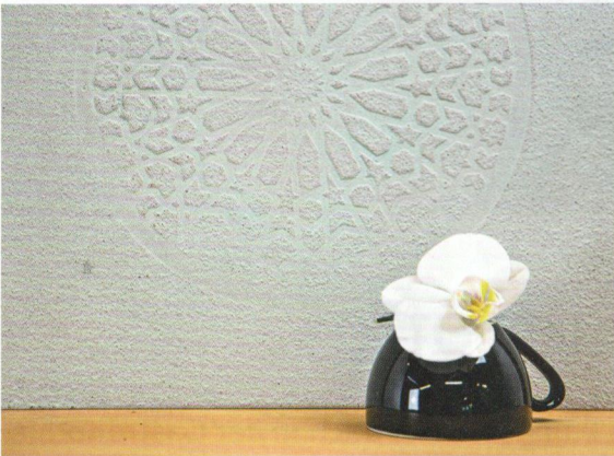
4 Lehmfeinputz-Stempeltechnik. Mit der weniger aufwändigen Stempeltechnik für Stuckateure bedeutet das schnellere arbeiten, auch Heimwerker können das Wunschdekor an die Wand bringen.
