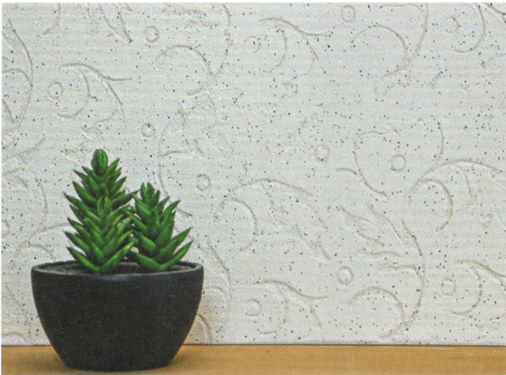
2 Lehmfeinputz-Prägewalze. Muster und Ornamente können auch mit der Prägewalze aufgebracht werden.
